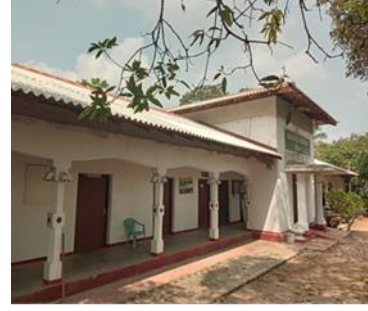
ඡායාරූප අංක 32 - ගාල්ල ඇල්පිටිය ගො.සේ.ම. වහල අළුත්වැඩියාව புகைப்பட எண் 32 - காலி எல்பிட்டிய கமநல சேவை நிலையக் கூரையைப் புழுதுபார்த்தல் Photo no 32 - Renovation of the Galle Alpititiyawa Agrarian Service Centre Roof
