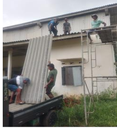
புகைப்பட எண் 41 - மெய்மையான டிபார்ட்மெண்ட் புகைப்பட எண் 41 - களஞ்சியங்களைப் பழுது பார்த்தல் Photo No 41 - Warehouse Renovation
