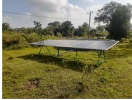
ඡායාරූප අංක 11 - ස්ථානය කරන ලද සූර්ය පැනලය ප්‍රදානය වූ 11 - නිවැරදිව පිටුපස තබා ගත Photo no 11 - The installed solar panel
