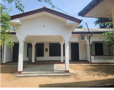
ඡායාරූප අංක 31 - මඩකලපුව දිස්ත්‍රික් කාර්යාලයේ රැස්වීම් ශාලාව புகைப்பட எண் 31 - மட்டக்களப்பு மாவட்ட அலுவலகத்தின் கூட்ட மண்டபம் Photo no 31 - Conference Hall of the Batticaloa District Office
