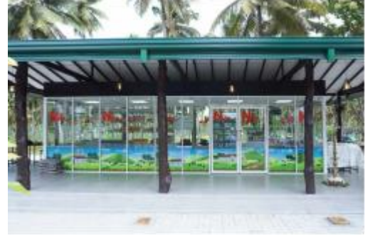
சூடார்பு அංක 28 – මාරවිල ගොවිපොළේ නව අලෙවි සැලකිල්ල புகைப்பட எண். 28 – மாவில பண்ணையில் புதிய விற்பனை நிலையமொன்றை நிர்மாணித்தல். Photo No. 28 – Construction of a new sales outlet at the Marawila farm
