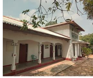
ඡායාරූප අංක 32 - ගාල්ල ඇල්පිටිය ග.ගේ.ම. වහල අළුත්වැඩියාව புகைப்பட எண் 32 - காலி எல்பிட்டிய கமநல சேவை நிலையக் கூரையைப் புழுதுபார்த்தல் Photo no 32 - Renovation of the Galle Alpititiyawa Agrarian Service Centre Roof
