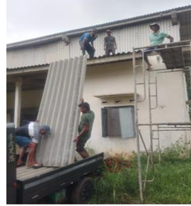
புகைப்பட எண் 41 - களஞ்சியங்களைப் பழுது பார்த்தல் Photo No 41 - Warehouse Renovation
