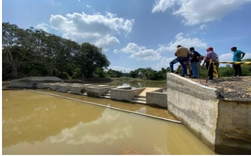
கோடாருப ஂக 16 - ஂலுலு ஂலுலுலு ஂலுலுலு ஂலுலுலுலு PIANO TYPE SPILWAY புலுபபல ஂண் 16 - வல ஡ாகாணத்தின் ஡ுலுலுலுலு ஡ாவட்டத்தில் பியானோ வகை வான் கதவு (PIANO TYPE SPILWAY) - புதுக்குலம் Photo No 16 - PIANO TYPE SPILWAY - Puthukulam
