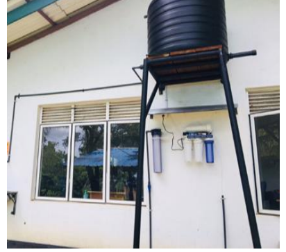
கூயாருப டீக 45 - காதிக்கார்டீக டீனூகலீ ஸூ ரீலீலீலீக ஸீலீபகலீ கீரீம், லெடீக காதி காக்கீக டீனூகலீ புகைப்பட எண் 45 - தொழில்நுட்ப வகை குடிநீர் வடிகட்டியை நிறுவுதல் - பட்டஅத்தயில் உள்ள விவசாய தொழில்நுட்ப பூங்கா Photo No 45 - Installation of Industrial Type Drinking Water Filter, Batatha Agro Technology Park
